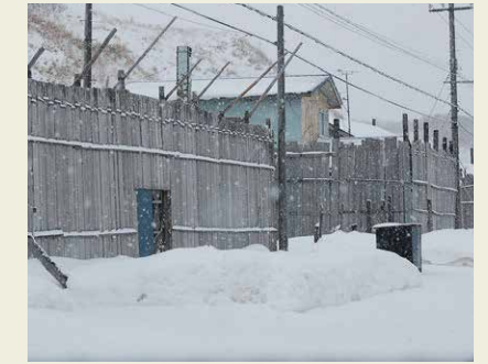
大波や強風から家を守るため、海側が高い板塀で覆われた民家。小平町から増毛町にかけての海岸付近で見られる。
