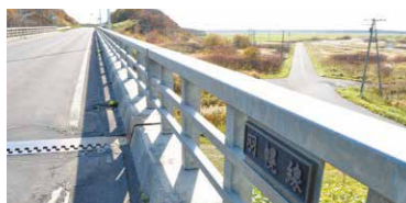
1 路線跡 (232 振老跨線橋より) 天塩町川口
