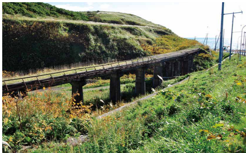
4 第三初山別橋梁跡(金駒内橋梁) 初山別村豊岬
