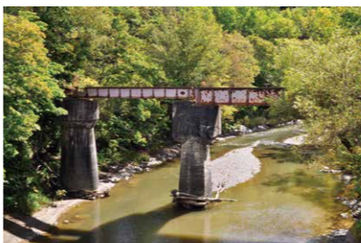
6 第二築別川橋梁跡 (356 鶴亀橋より) 羽幌町曙
