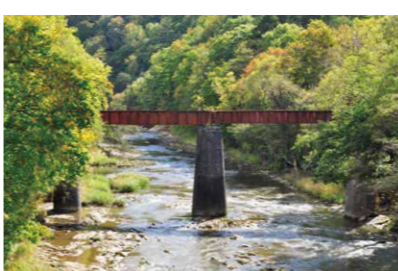
5 第一築別川橋梁跡 (356 春水橋より) 羽幌町曙
