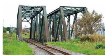
12 南岸線鉄橋跡 留萌市栄町
