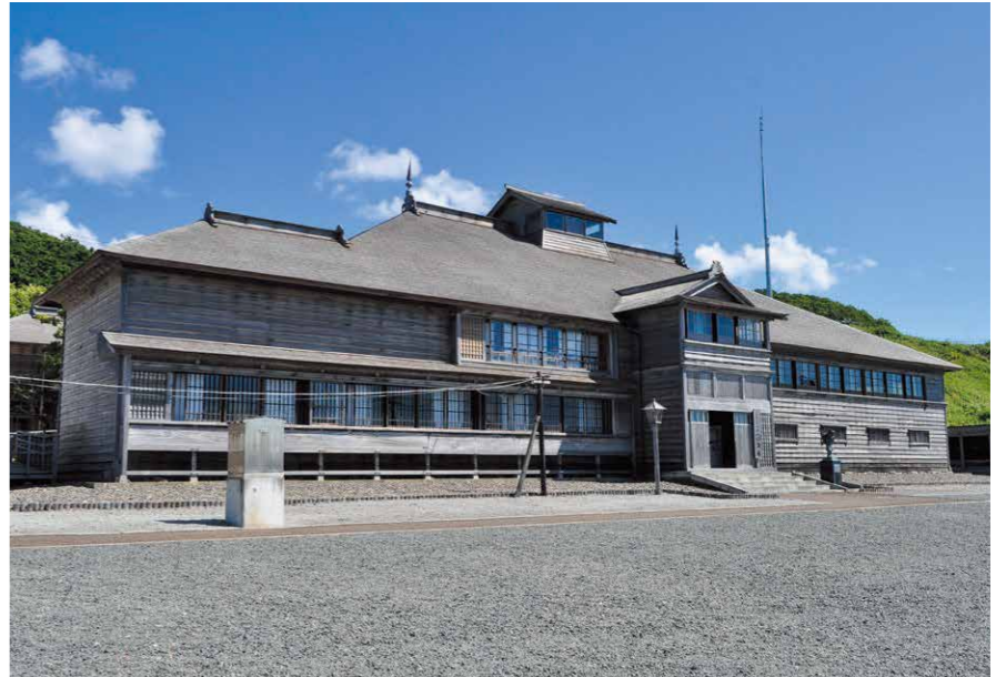
上／重要文化財指定とともに町が買収し、3年の歳月と約1億9千万円の費用を投じて解体修復。道の駅おびろが併設され、小平町やニシン漁文化の歴史を伝えている。左下／延べ床面積906㎡の番屋の内部。使用されている木材はほとんどが近隣の山林から調達されたものであることがわかっている。左下／漁盛期には200人ものヤン衆が寝泊りしたという大規模番屋。各所に設えられた贅を尽くした意匠が、当時の繁栄ぶりを示している。
